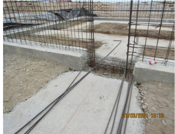
Construcción Nueva Subestación Eléctrica – DGAC.
