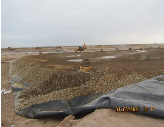
Construcción Nuevo Edificio Logístico – DGAC.
