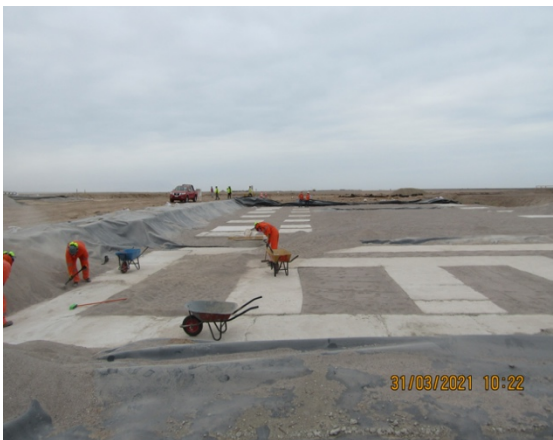
Construcción Nuevo Edificio SSEI – DGAC.
