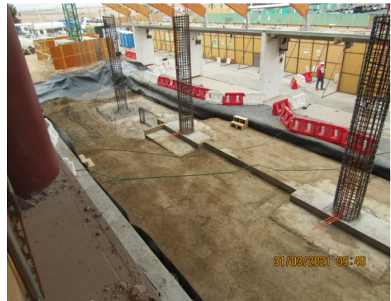
Ampliación Terminal de Pasajeros.
